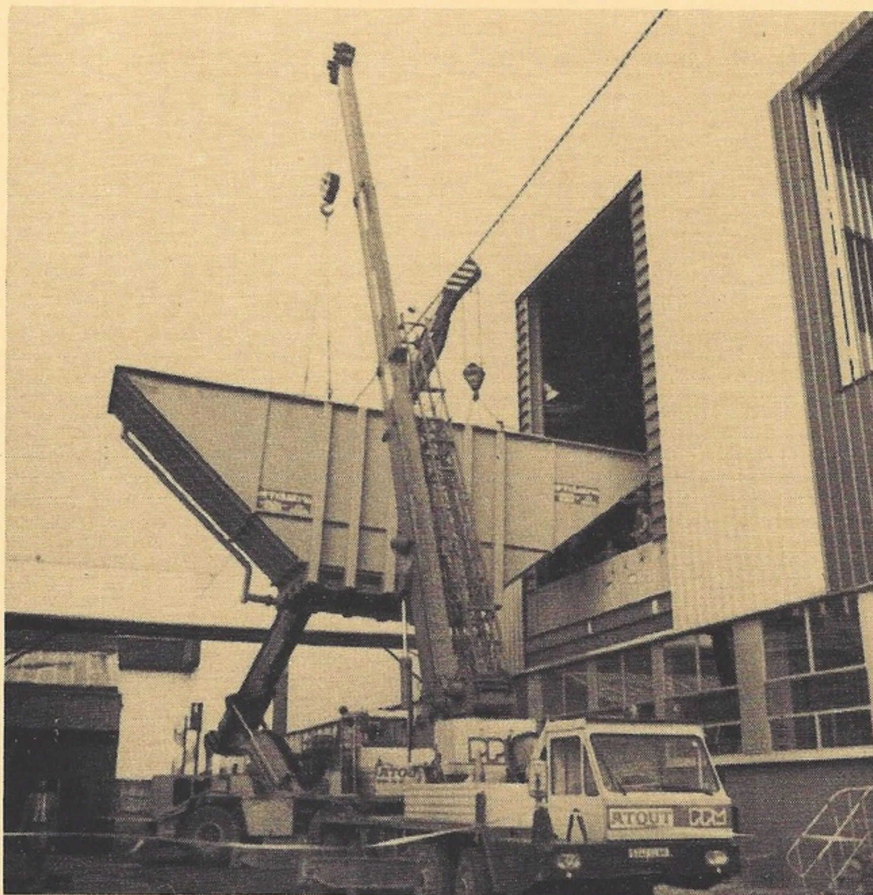
La première cuve arrive
