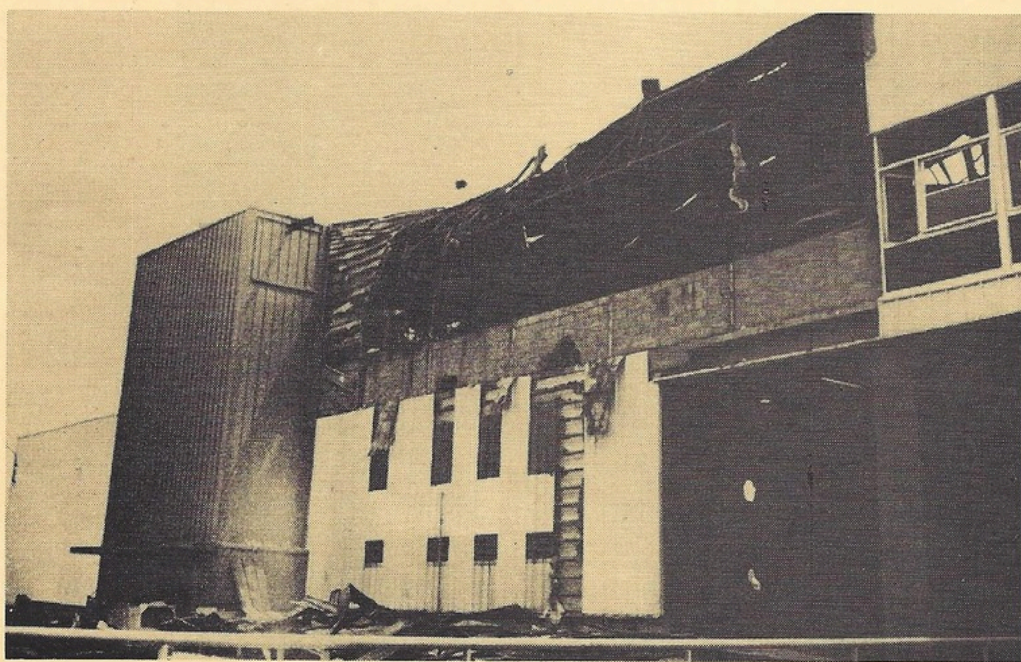
Façade du bâtiment R8, après l'incendie.
