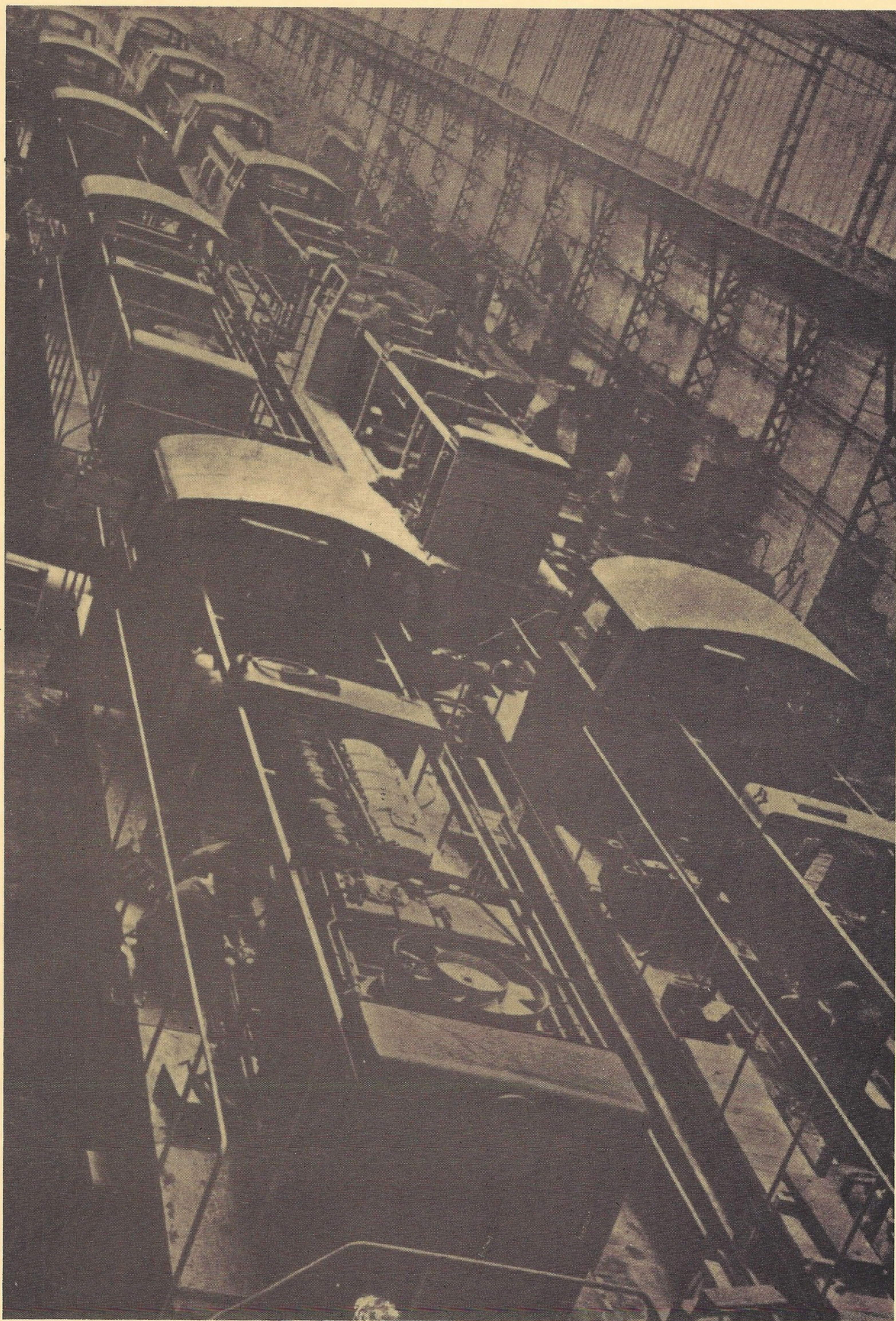
Montage des locomotives "040 DE" au bâtiment Q
