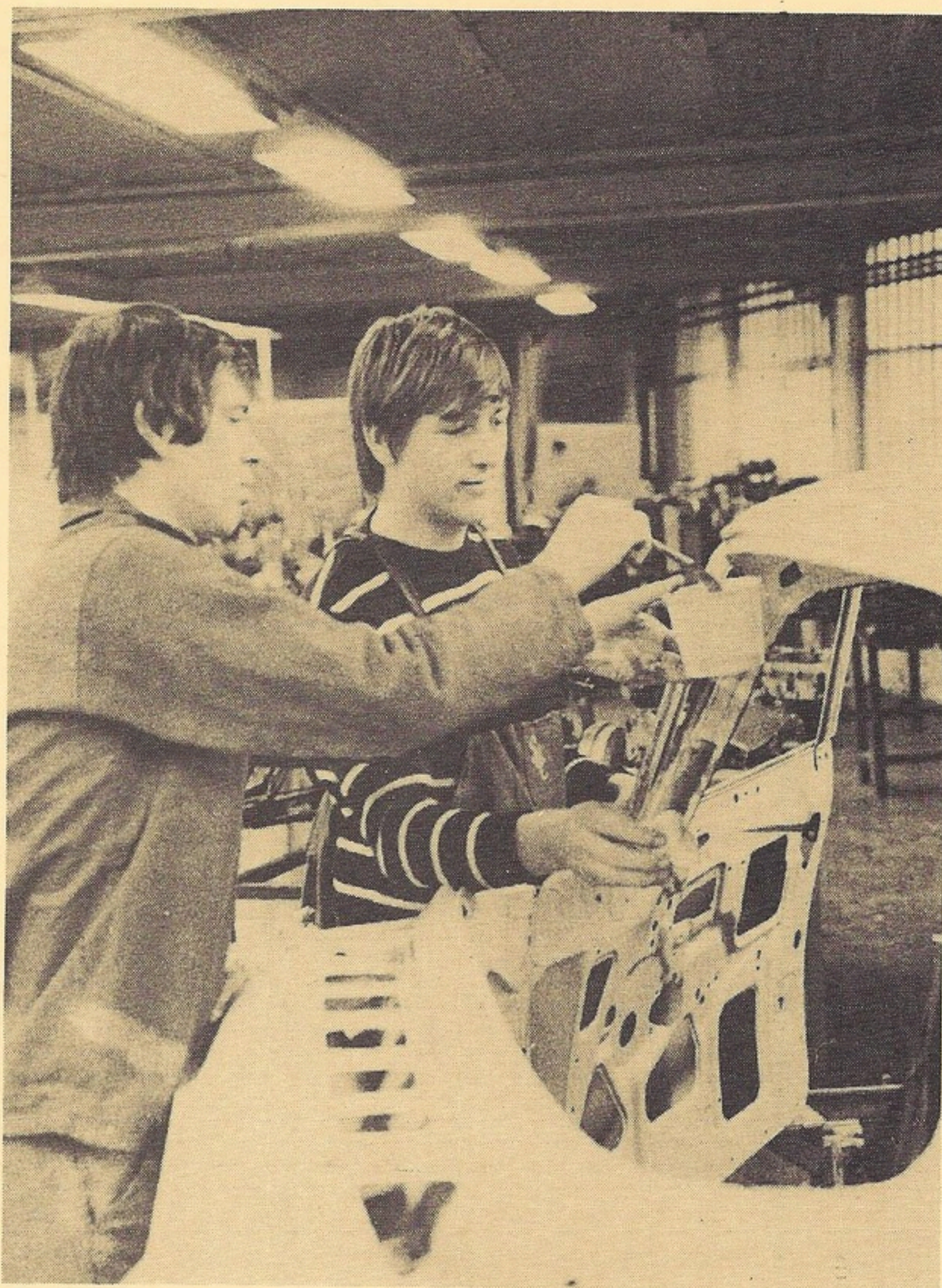
Stage garnissage : montage de pare-brise.
