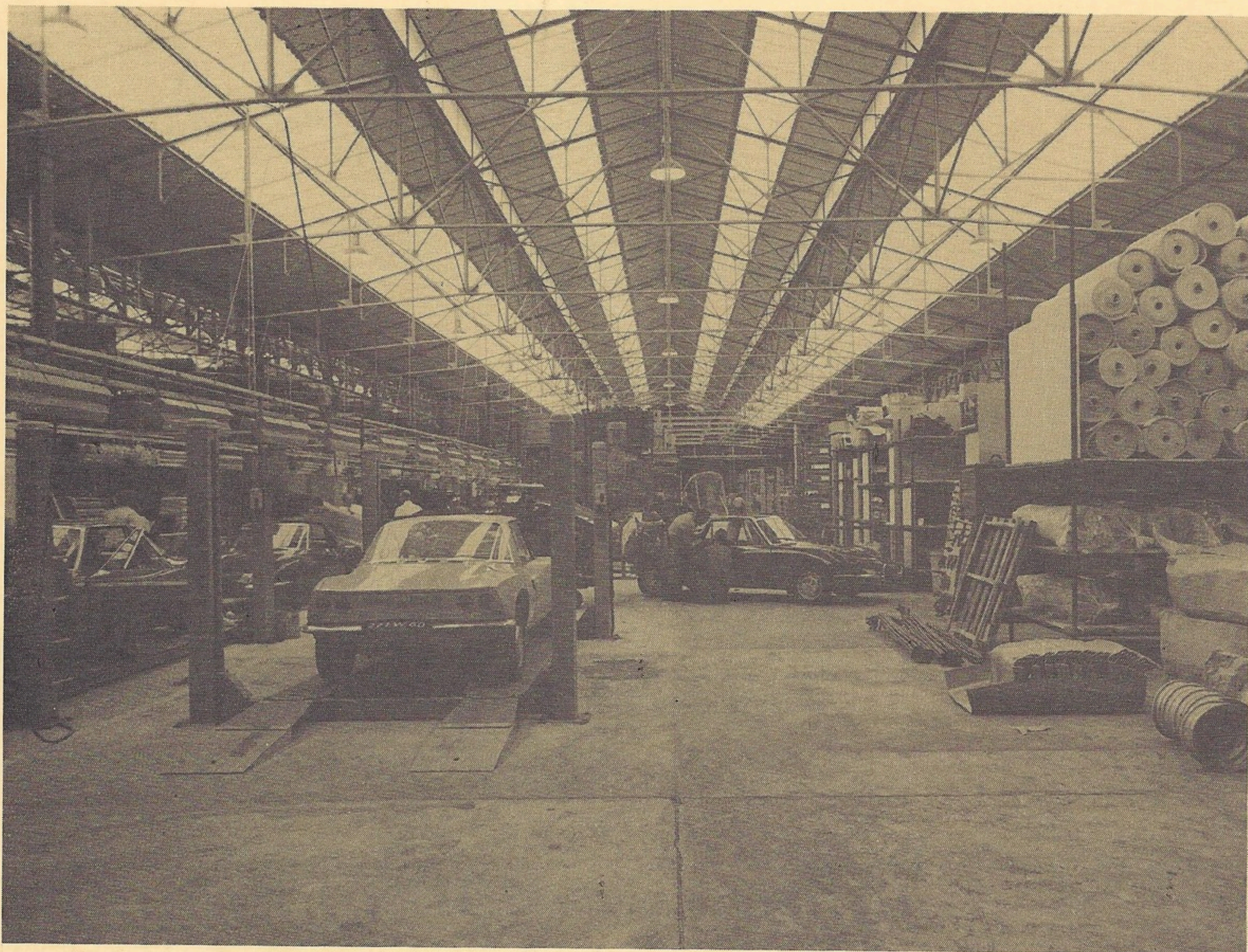
Aménagements intérieurs des ateliers MATRA aux bâtiments R5 et R6.
