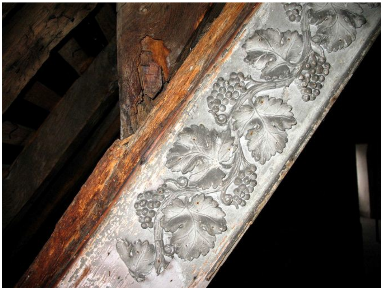
Lincoir de la charpente des combles sculpté de feuilles de vignes et de grappes de raisin.
