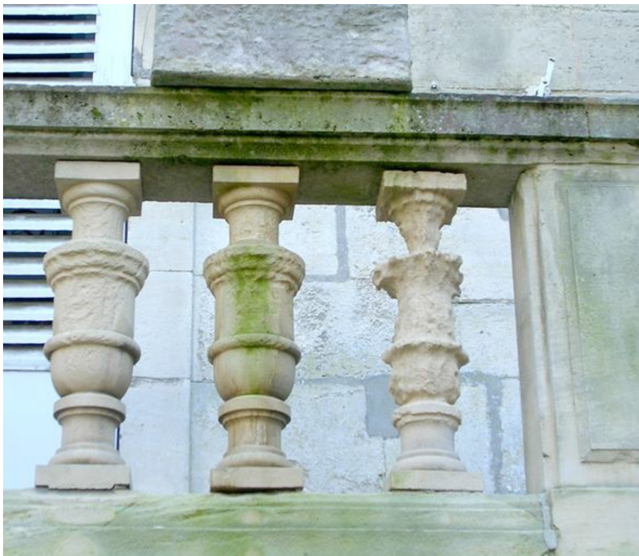
Détail des balustres en pierre de l'escalier.
